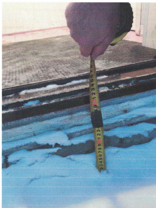
Фото №5. Порог входа №2 на высоте 220мм
