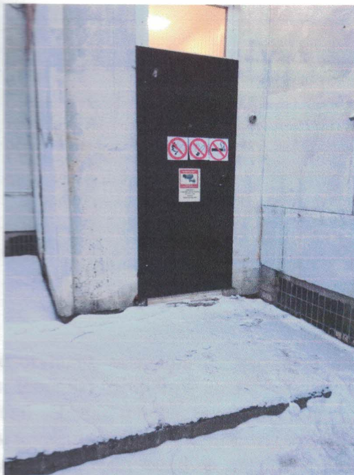
Фото №4. Вход №2 в здание детского сада
