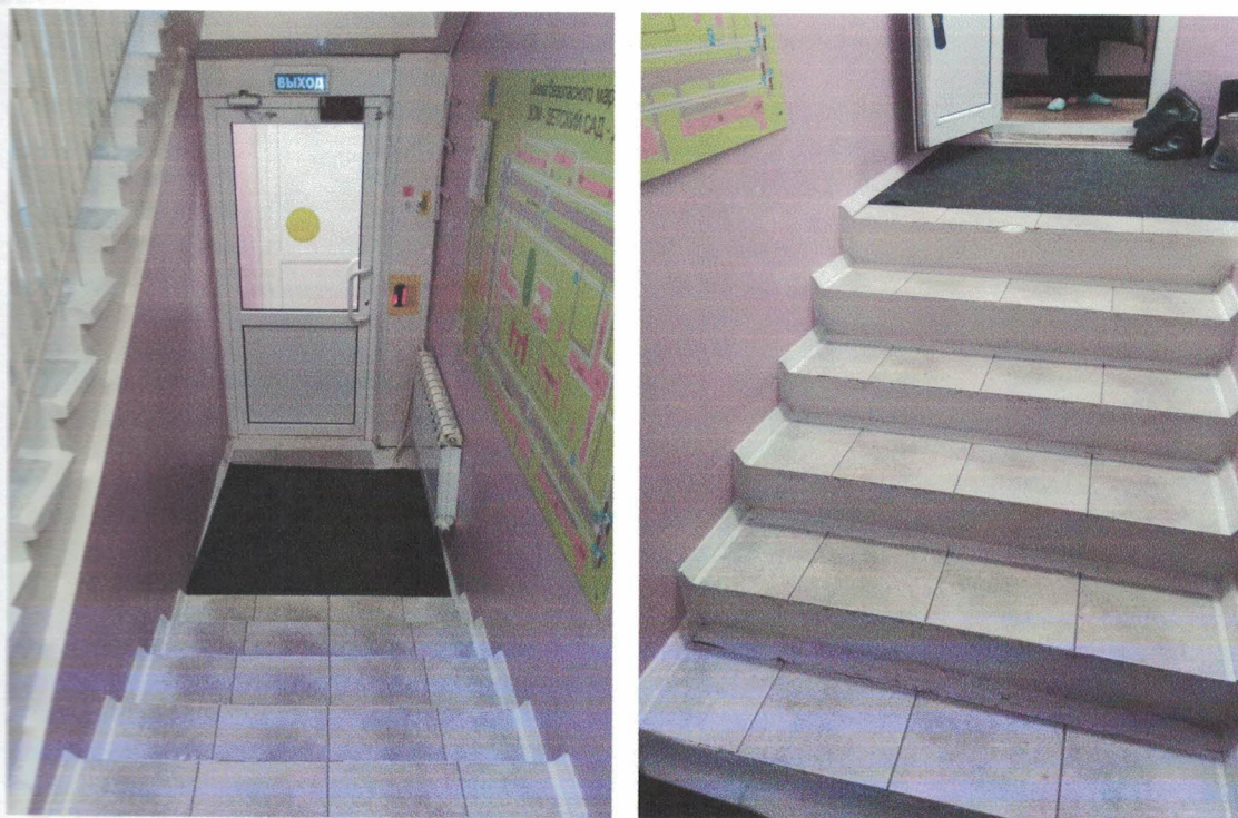
Фото №2. Лестница центрального входа в здание
