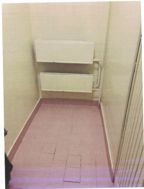
Фото №5. Тамбур входа №2 шириной 1170мм
