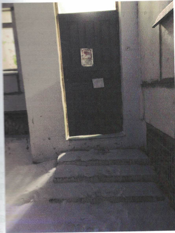
Фото №4. Вход №2 в здание детского сада
